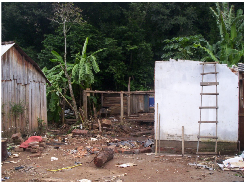
Foto 03 – Enxurrada 2008 – Destruição total de casa – Localidade Vila Nova
